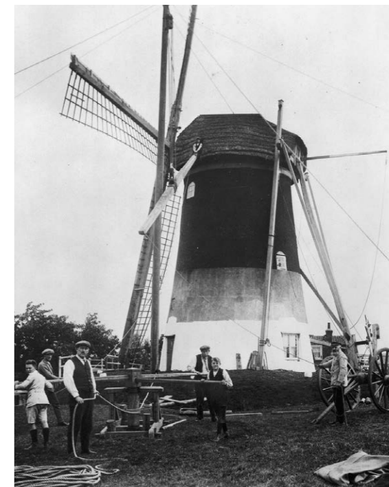
Zomer 1924, molenaar Yperlaan met familieleden en personeel steekt een lange spruit door middel van een schalk, een hijsmast en een kaapstader. Zwaar werk, met na afloop een klein feestje met bier. Foto Rijksdienst voor Monumentenzorg
