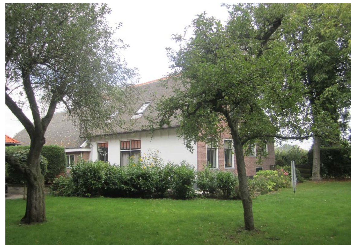
Boerderij Rosenburgh, het woonhuis van de directeur en kantoor. Foto Mike Weston
