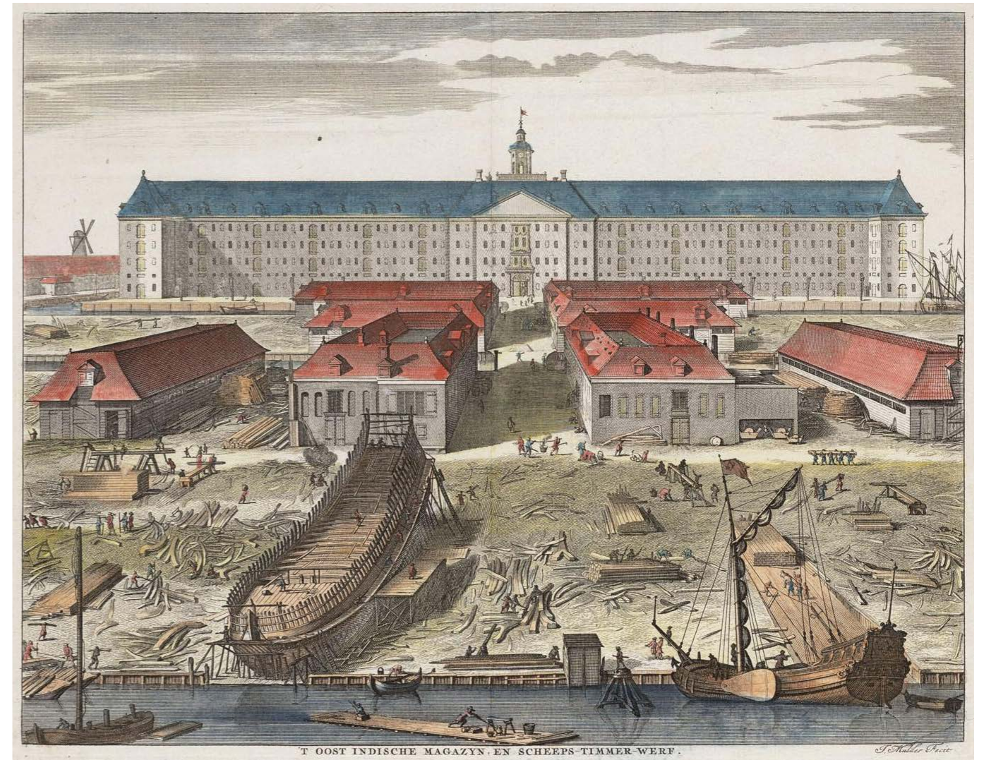
Oost-Indisch Magazijn en Scheepstimmerwerf te Amsterdam, waar VOC in het tweede schip Voorschoten gebouwd werd. Prent van Joseph Mulder, 1726. Wikimedia Commons
