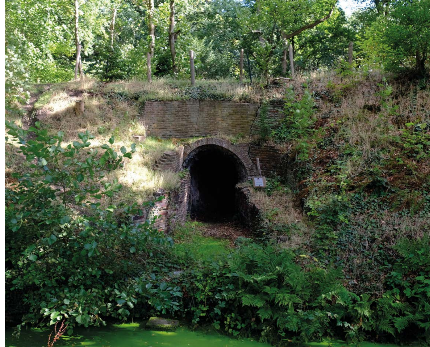
Westelijke entree doorgang, foto auteur 2018
